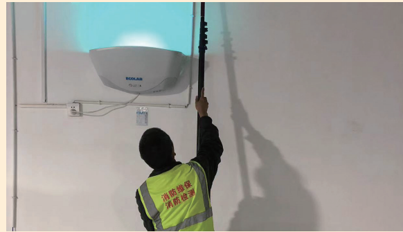
应急照明设备检查
