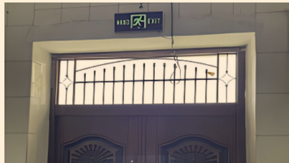
安全指示灯牌整改
