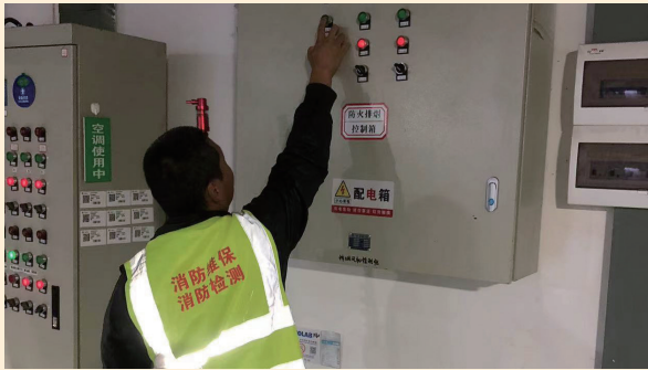
配电柜安全检查
